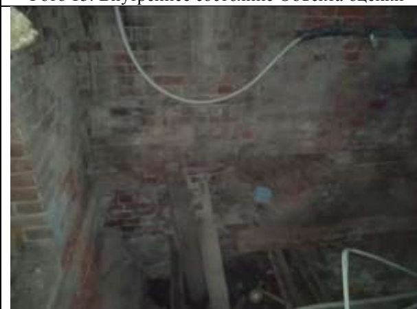
Фото 15. Внутреннее состояние Объекта оценки
