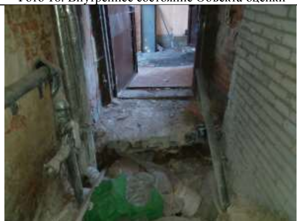
Фото 18. Внутреннее состояние Объекта оценки
