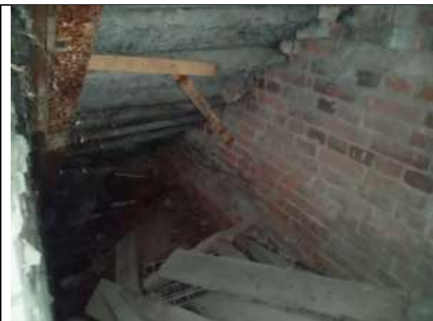
Фото 13. Внутреннее состояние Объекта оценки
