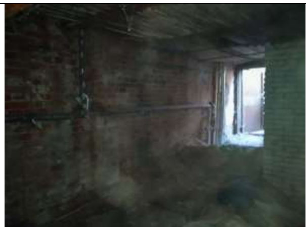
Фото 14. Внутреннее состояние Объекта оценки
