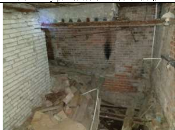
Фото 16. Внутреннее состояние Объекта оценки
