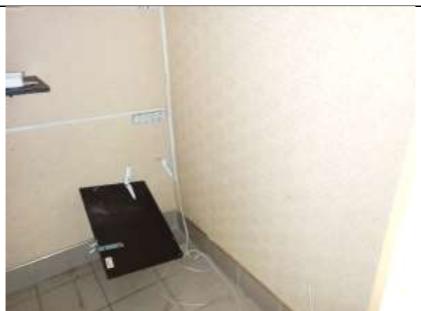
Фото 12. Внутреннее состояние Объекта оценки
