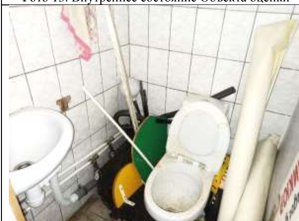
Фото 15. Внутреннее состояние Объекта оценки
