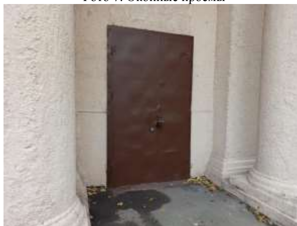
Фото 9. Общий вход с улицы (закрыт)
