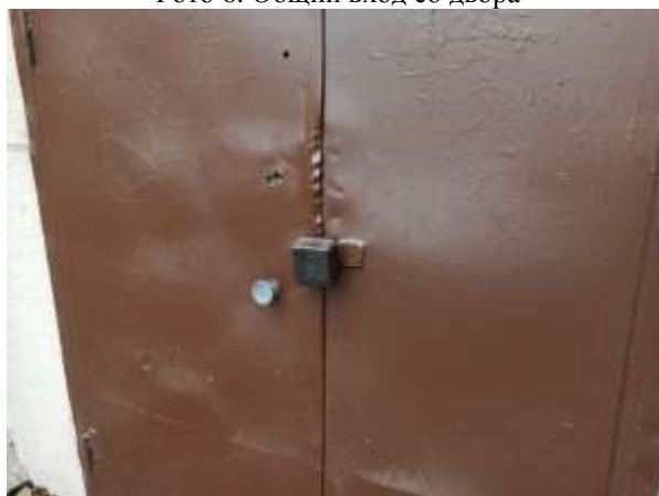
Фото 8. Общий вход с улицы (закрыт)
