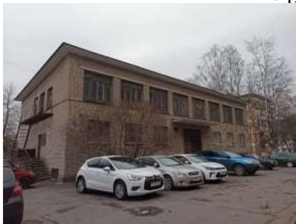
Фото 1. Вид здания, в котором расположен Объект оценки
