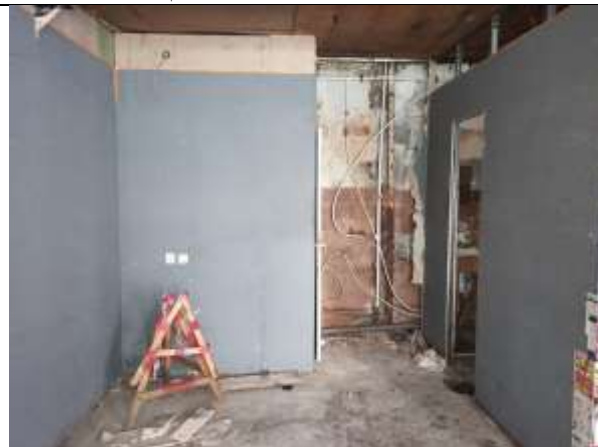
Фото 10. Внутреннее состояние Объекта оценки
