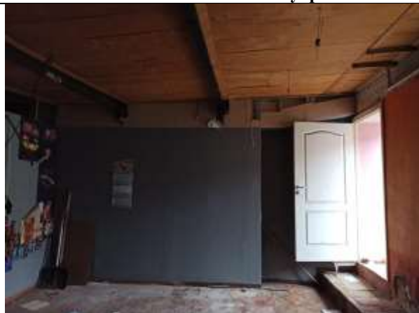
Фото 9. Внутреннее состояние Объекта оценки
