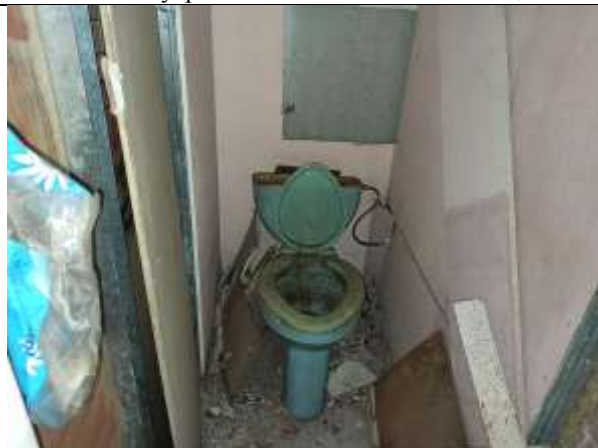
Фото 11. Внутреннее состояние Объекта оценки
