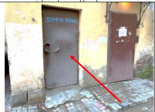
Фото 24. Вход в Объект оценки
