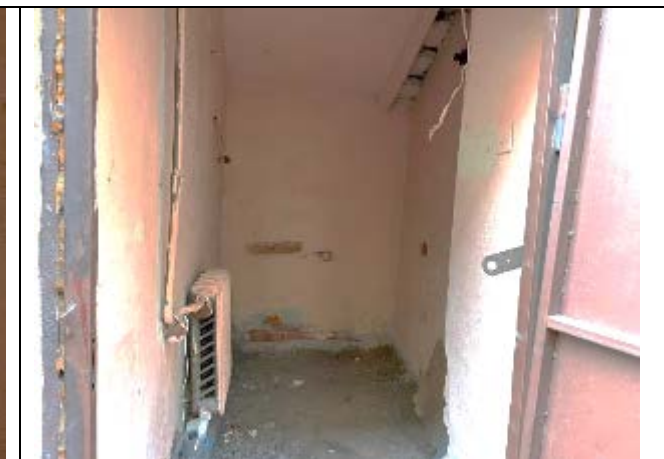
Фото 26. Типичное состояние Объекта оценки
