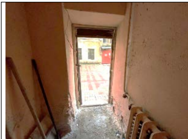
Фото 25. Вход в Объект оценки
