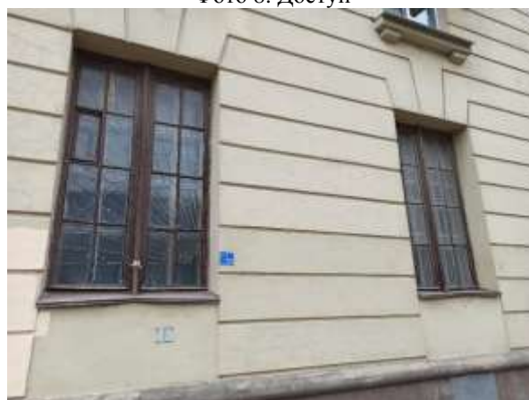
Фото 10. Окна, выходящие на улицу
