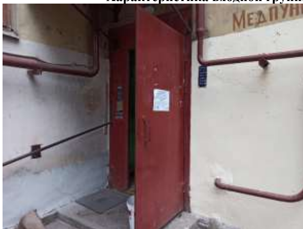
Фото 7. Общий вход со двора
