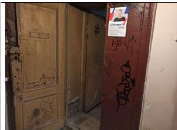
Фото 9. Вход Объекта оценки
