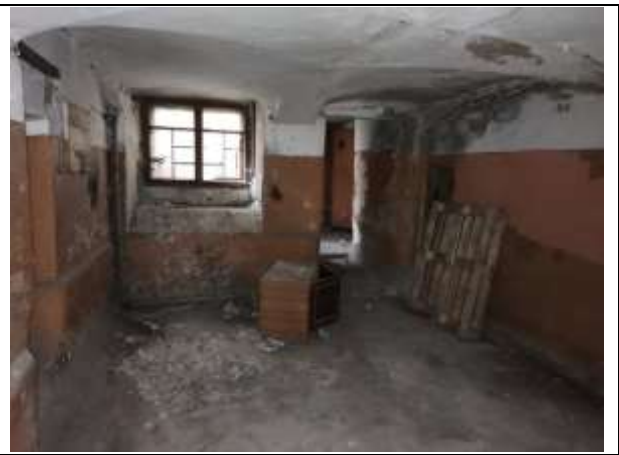
Фото 24. Внутреннее состояние Объекта оценки
