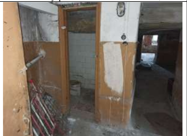
Фото 28. Внутреннее состояние Объекта оценки
