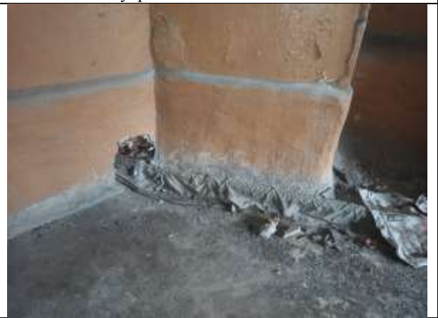
Фото 30. Внутреннее состояние Объекта оценки
