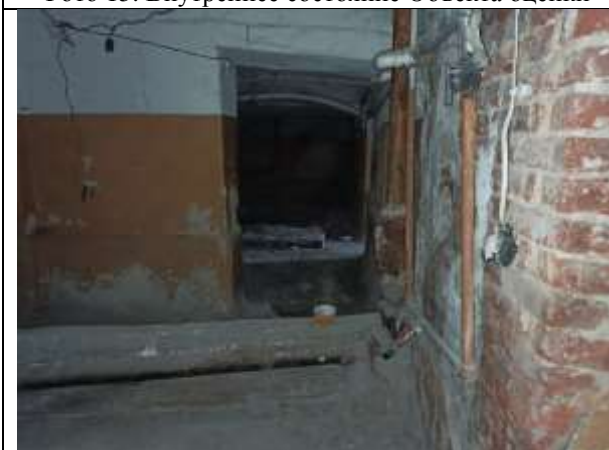
Фото 17. Внутреннее состояние Объекта оценки
