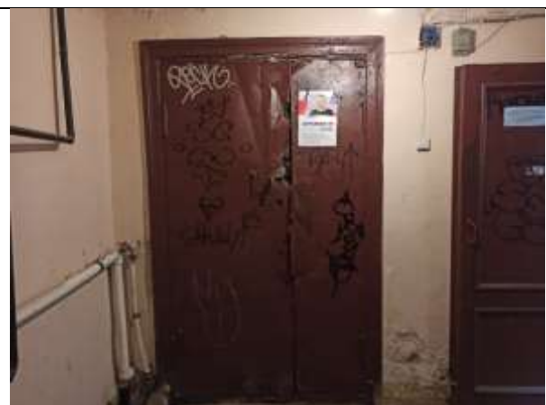
Фото 10. Вход Объекта оценки
