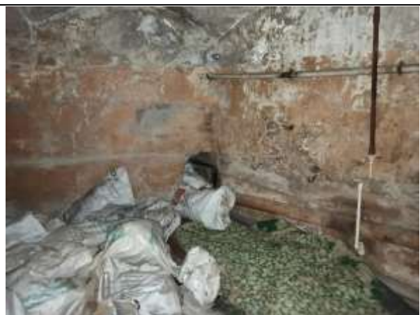
Фото 16. Внутреннее состояние Объекта оценки
