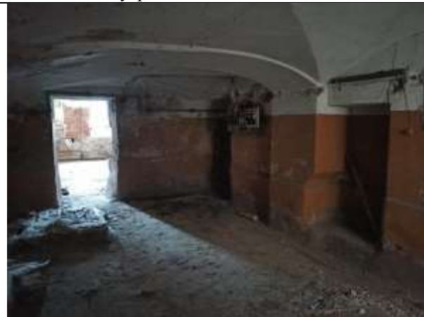
Фото 25. Внутреннее состояние Объекта оценки
