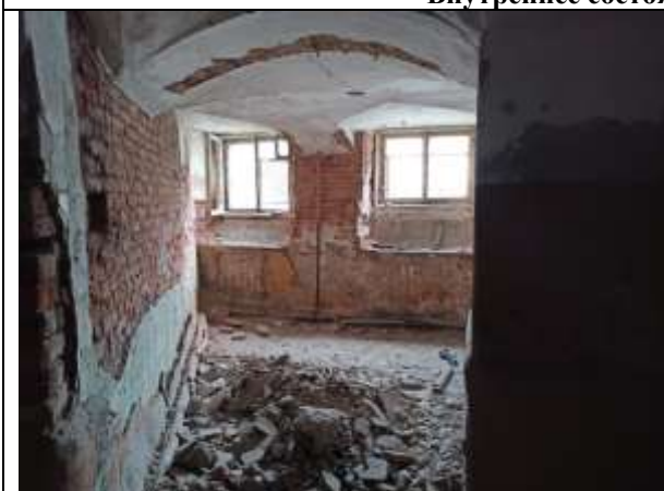
Фото 11. Внутреннее состояние Объекта оценки
