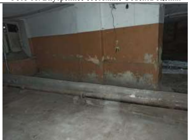
Фото 18. Внутреннее состояние Объекта оценки
