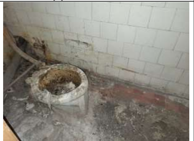
Фото 26. Внутреннее состояние Объекта оценки
