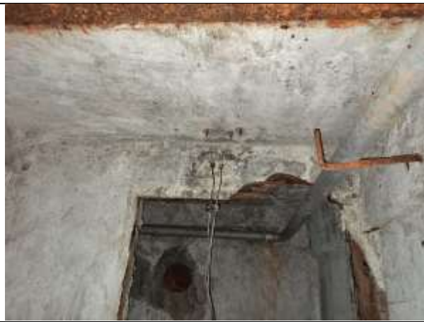
Фото 13. Внутреннее состояние Объекта оценки
