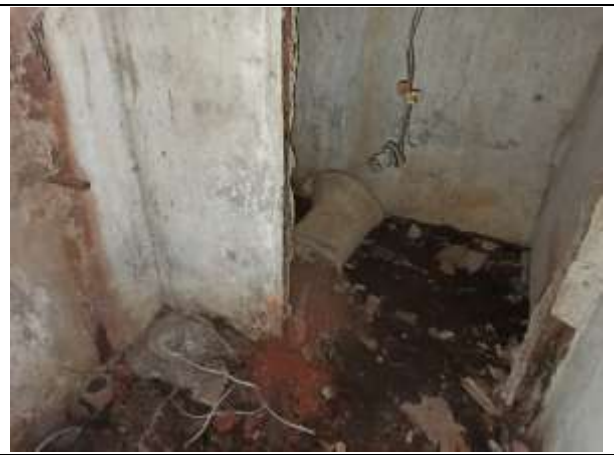
Фото 14. Внутреннее состояние Объекта оценки
