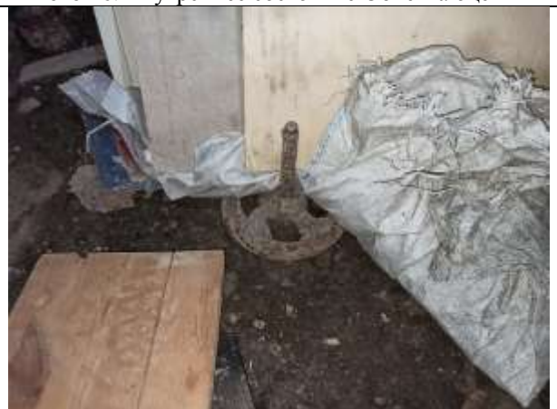
Фото 18. Внутреннее состояние Объекта оценки
