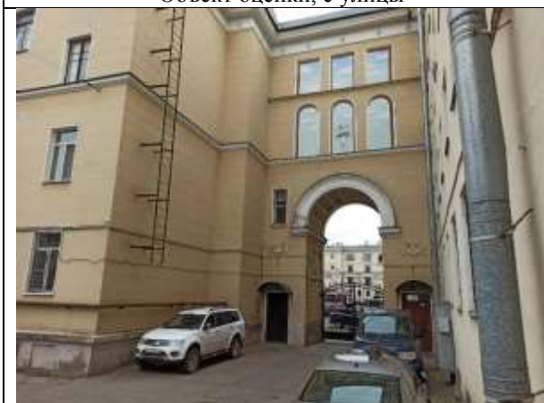
Фото 3. Вид здания, в котором расположен Объект оценки, со двора, доступ
