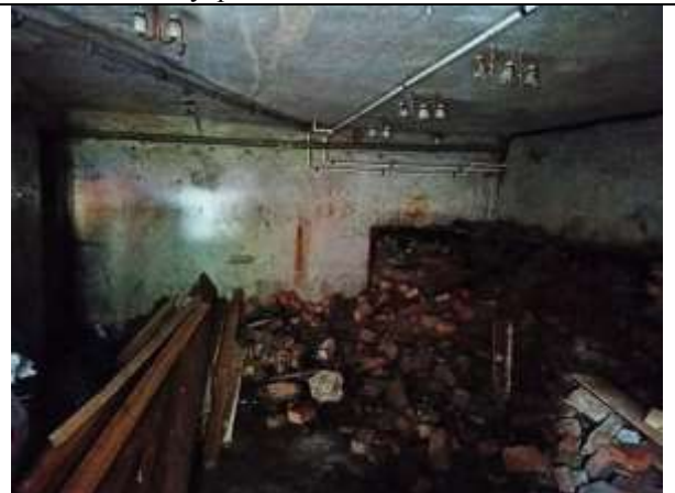
Фото 16. Внутреннее состояние Объекта оценки
