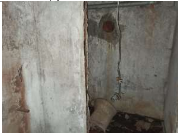
Фото 15. Внутреннее состояние Объекта оценки
