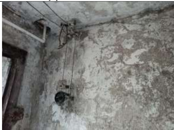
Фото 19. Внутреннее состояние Объекта оценки
