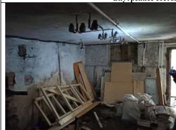
Фото 11. Внутреннее состояние Объекта оценки
