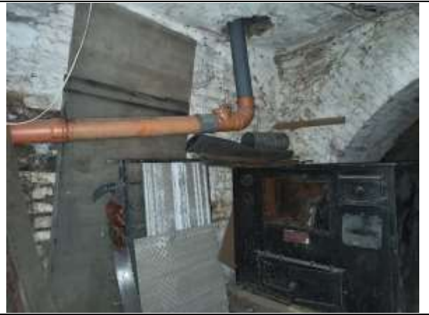
Фото 16. Внутреннее состояние Объекта оценки
