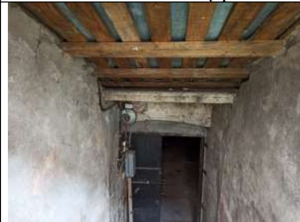
Фото 11. Внутреннее состояние Объекта оценки
