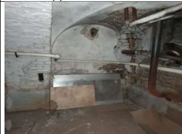
Фото 13. Внутреннее состояние Объекта оценки
