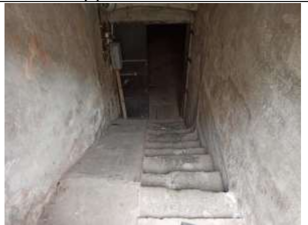
Фото 18. Внутреннее состояние Объекта оценки
