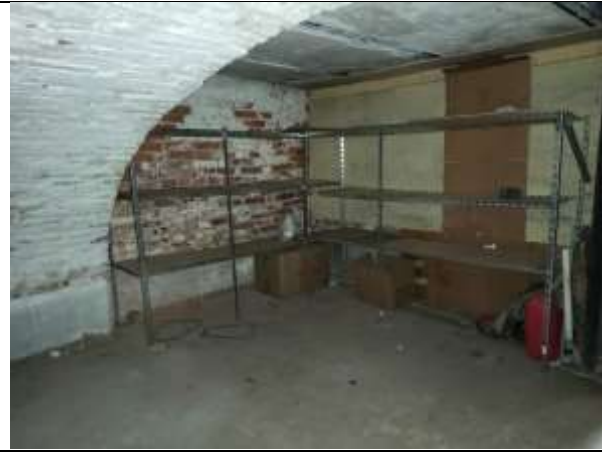
Фото 15. Внутреннее состояние Объекта оценки
