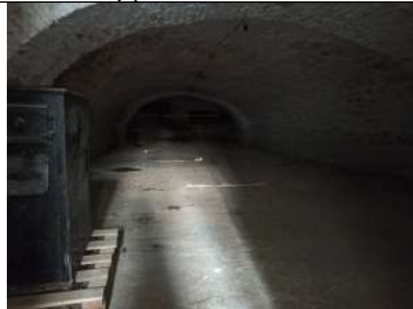
Фото 17. Внутреннее состояние Объекта оценки
