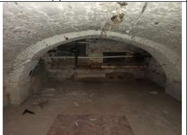
Фото 14. Внутреннее состояние Объекта оценки
