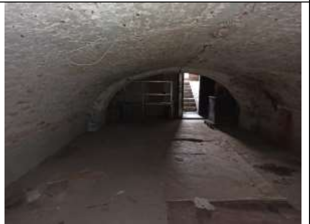
Фото 12. Внутреннее состояние Объекта оценки
