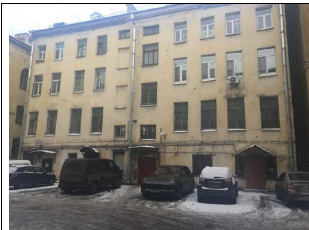
Фото 10. Вид здания Объекта оценки (со стороны двора)
