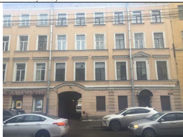
Фото 7. Вид здания Объекта оценки (со стороны улицы)
