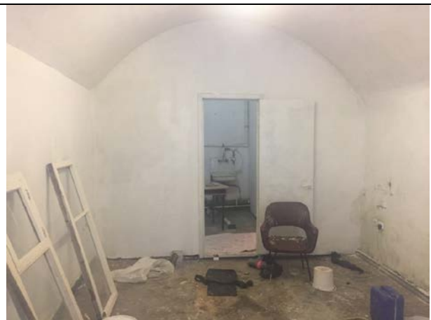
Фото 20. Типичное состояние Объекта оценки
