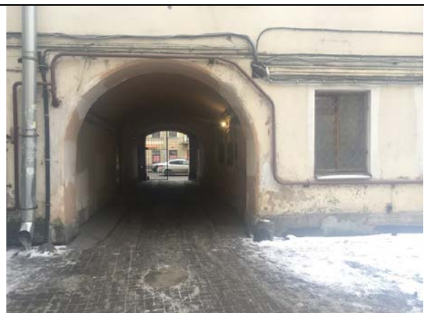
Фото 8. Проход через арку к зданию Объекта оценки
