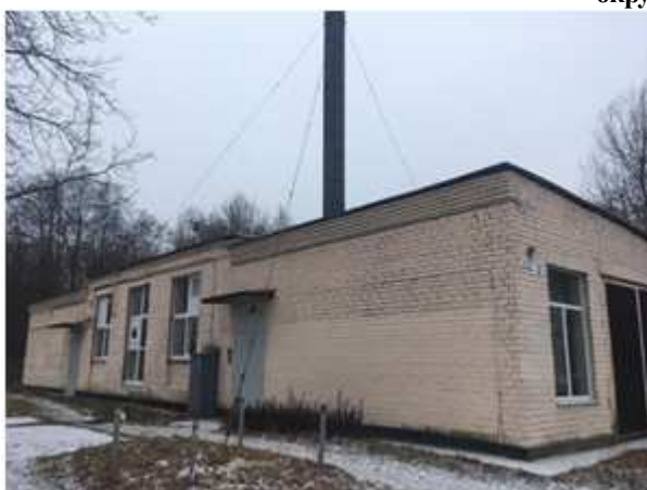
Фото 1. Вид здания, в котором расположен Объект оценки
