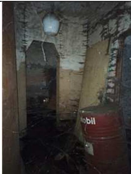
Фото №8 Внутреннее состояние Объекта оценки
