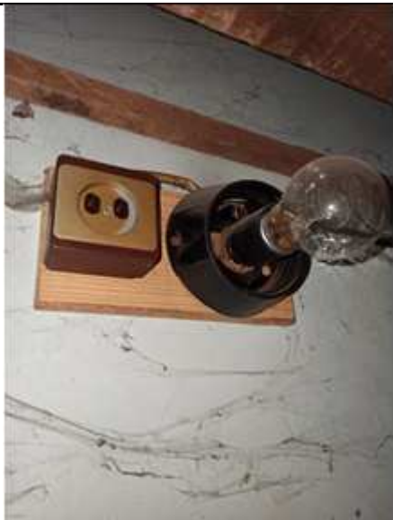
Фото №13 Элементы инженерной инфраструктуры
