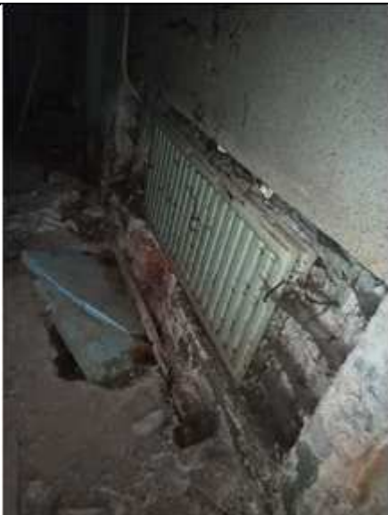
Фото №7 Элемент инженерной инфраструктуры
