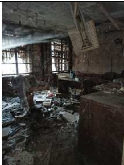
Фото №10 Внутреннее состояние Объекта оценки
