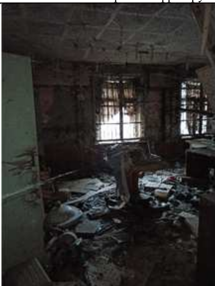
Фото №9 Внутреннее состояние Объекта оценки
