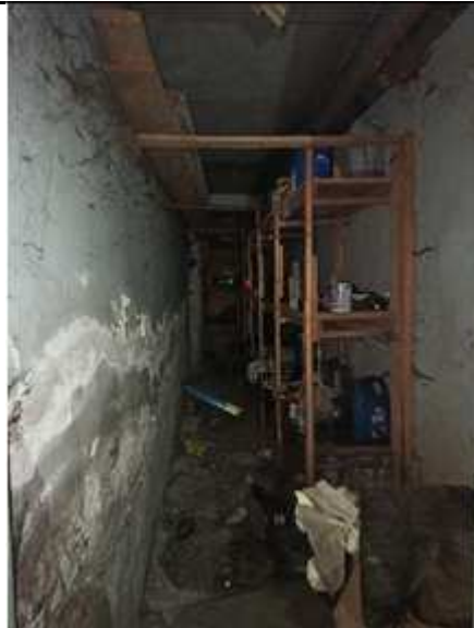
Фото №12 Внутреннее состояние Объекта оценки
