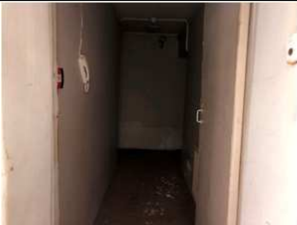
Фото 9 Вид помещения 1-Н
