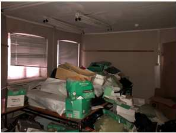
Фото 11 Вид помещения 1-Н
