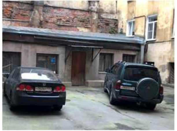
Фото 8 Вход в помещение
