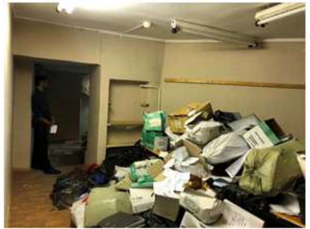
Фото 12 Вид помещения 1-Н
