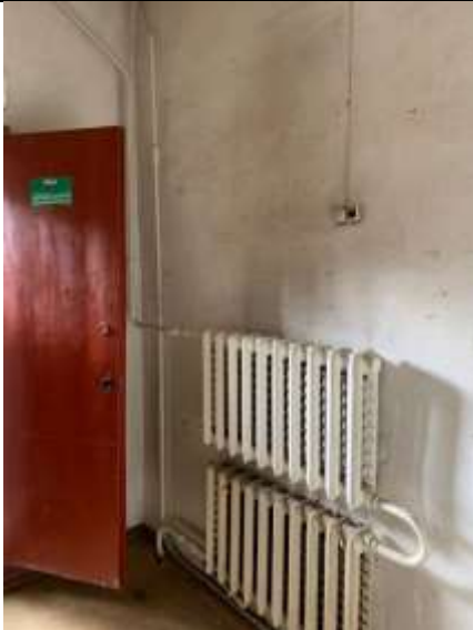
Фото №9. Внутренний вид ч.п. 1
