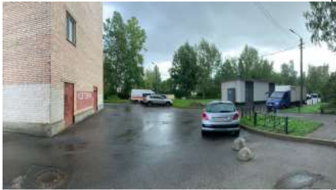
Фото №5 Входы в помещение
