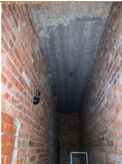
Фото №19 Внутренний вид ч.п. 3
