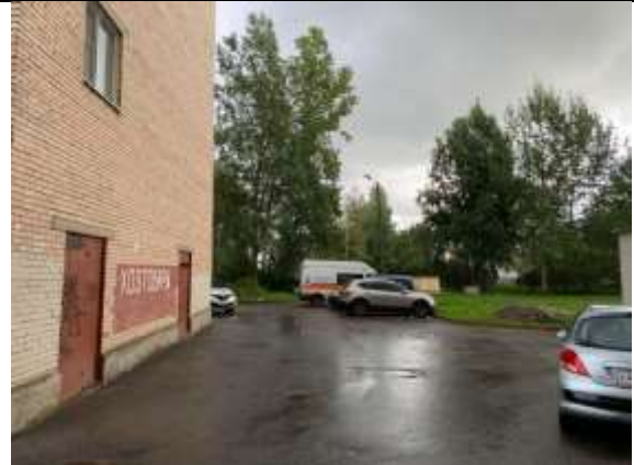
Фото №6. Входы в помещение
