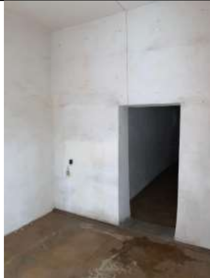
Фото №10 Внутренний вид ч.п. 1. Вход в ч.п. 2
