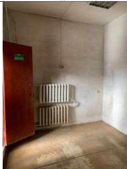
Фото №8 Внутренний вид ч.п. 1
