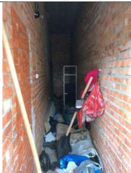
Фото №18 Внутренний вид ч.п. 3
