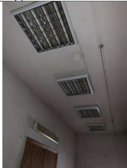
Фото №14 Внутренний вид ч.п. 2
