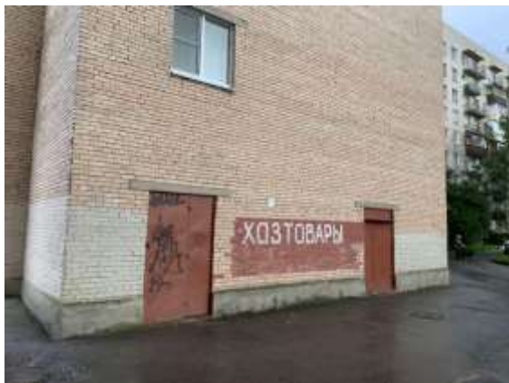
Фото №7 Входы в помещение
