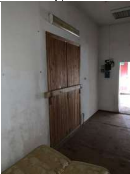
Фото №13 Внутренний вид ч.п. 2
