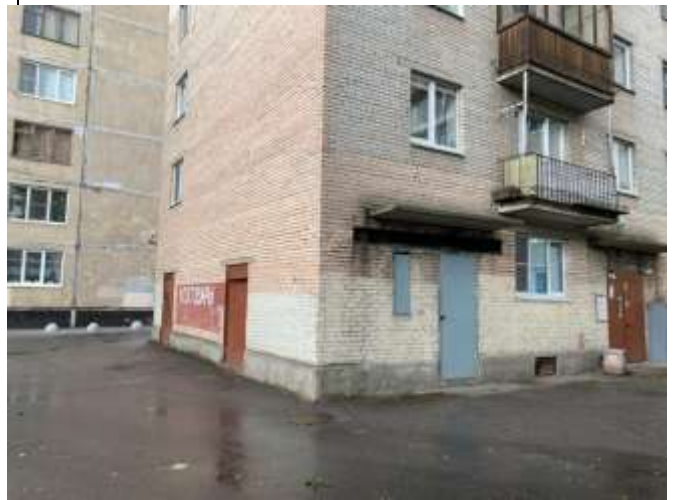
Фото №16. Входы в помещение
