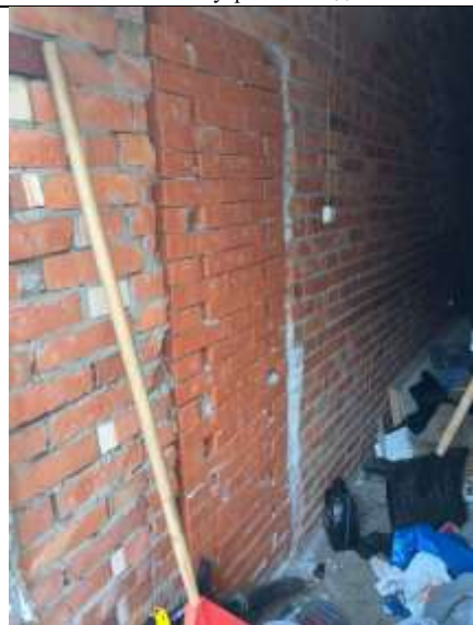
Фото №20 Внутренний вид ч.п. 3. Заложенный вход в ч.п. 2
