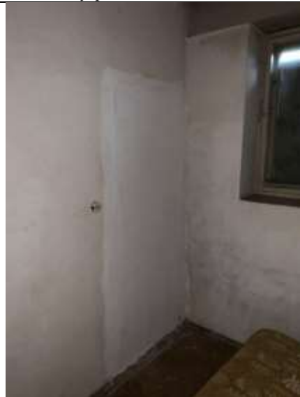
Фото №12 Внутренний вид ч.п. 2. Заложенный вход в ч.п. 3
